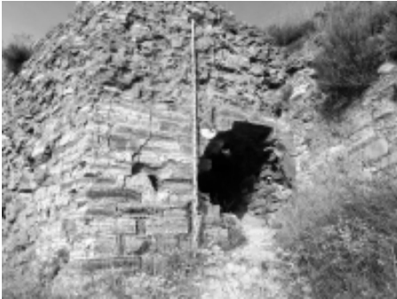
Porta monumental d'accés al recinte fortificat
