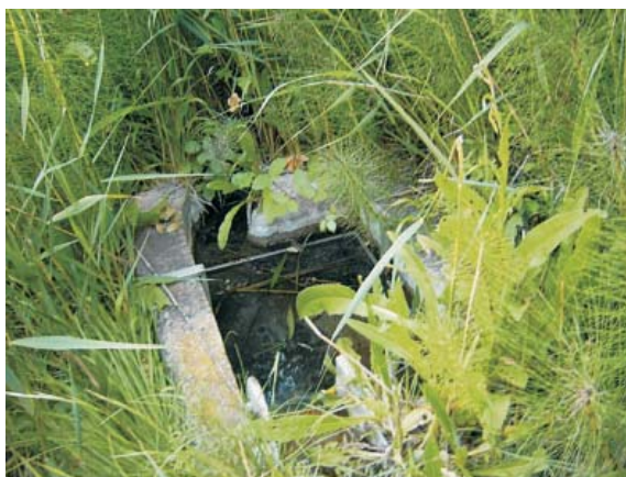
Font de cal Barrusca: font situada als Quadrells que neix a les proximitats de cal Barrusca. Una petita canal recull l'aigua des del seu naixement i la porta a una arqueta que permet, a l'obrir-se, que l'agua flueixi cap als horts.
