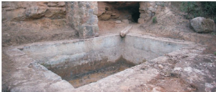
Estat en què ha quedat la font recuperada
