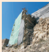
Obres al castell de Sant Esteve de Castellfolit
